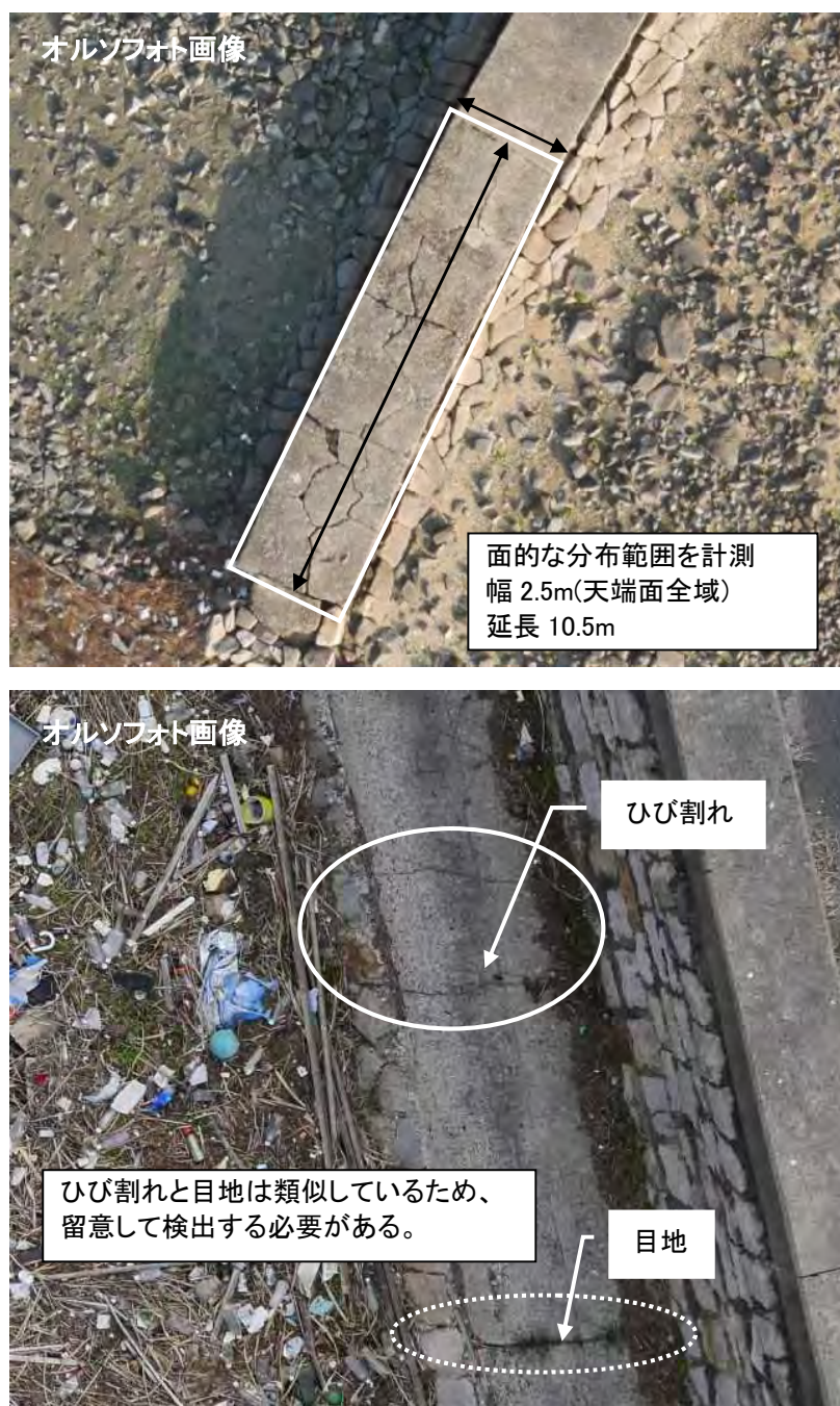
図7.2 ひび割れの検出例
