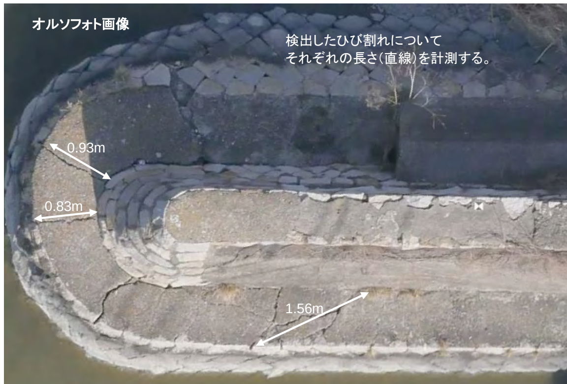
図7.3 ひび割れ長さの計測例
