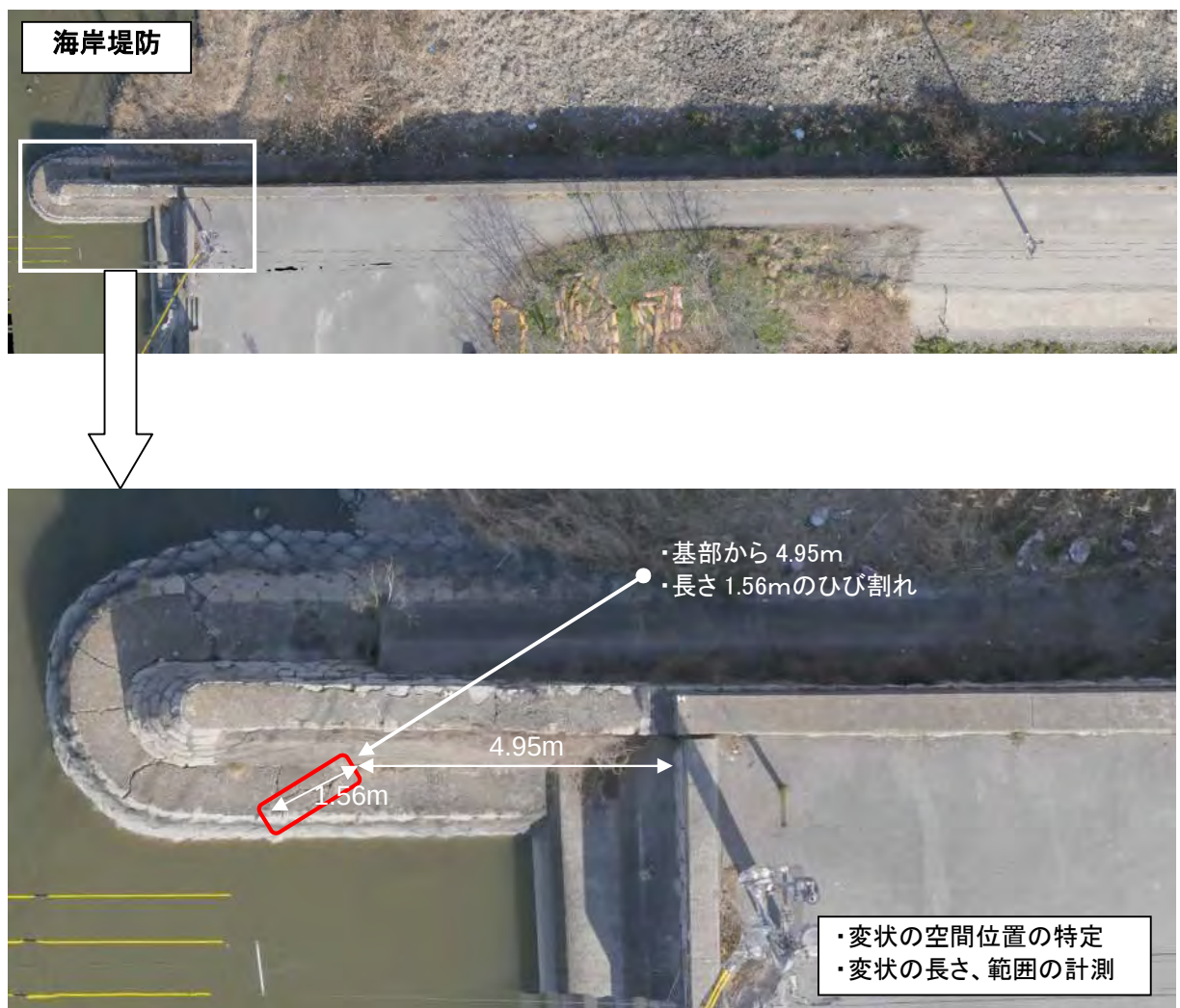
図5.4 オルソフォト画像(海岸堤防の例)
