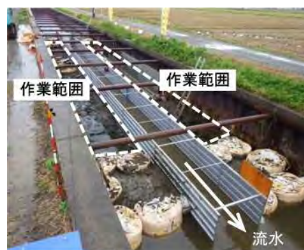
図-7 鋼製組立式仮設水路による仮締切
