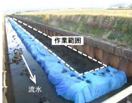
図-6 大型土のうによる仮締切
