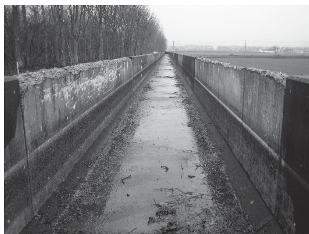
図（７）－２６ 水路更生工法の適用前の概況
