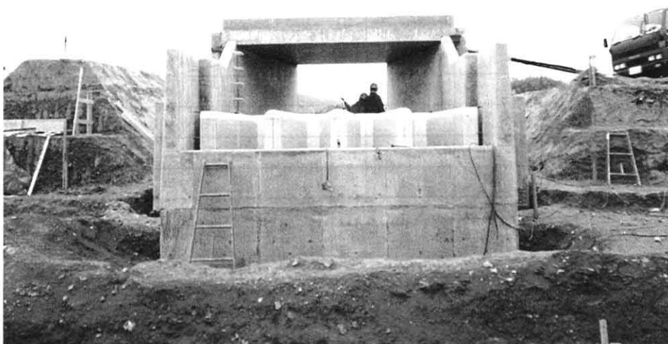
写真一 製品セット後全景 1
