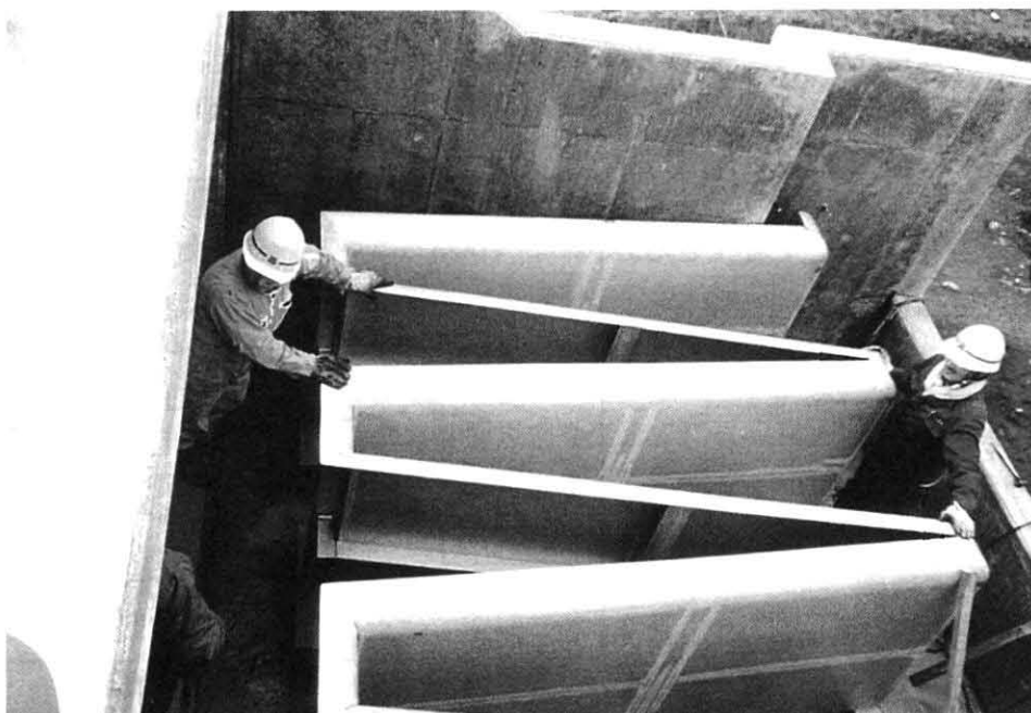
写真一 締結完了
