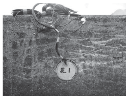
図（7）- 5 テストピースの設置状況
