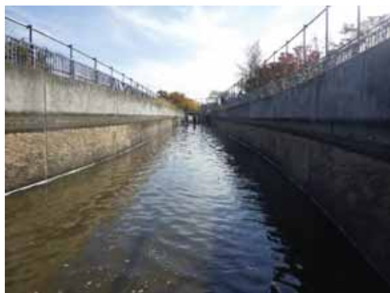
写真-1 施工前（撮影方向 上流→下流）
