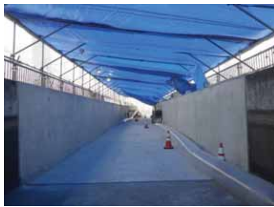
写真-4 施工後（撮影方向 下流→上流）
