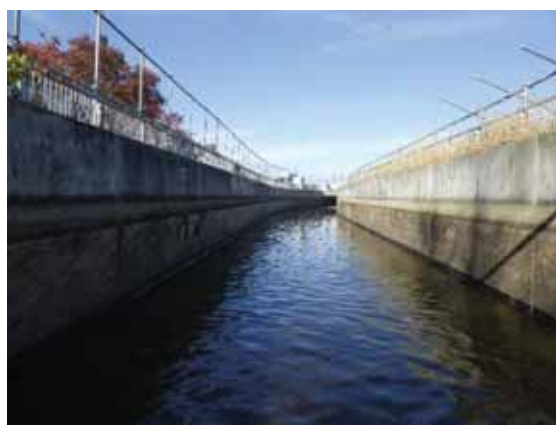
写真-2 施工前（撮影方向 下流→上流）
