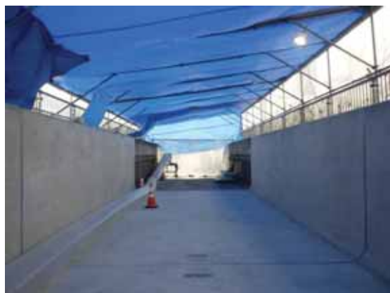
写真-3 施工後（撮影方向 上流→下流）
