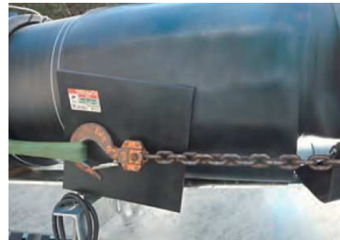
写真 4-3-2 レバーブロック 干渉部の保護
