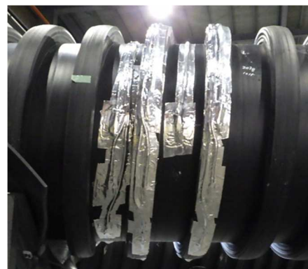
図 30. 管周方向測定用の ひずみゲージ貼付状況
