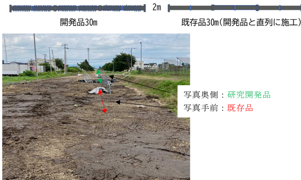
図 26. 供試管埋戻し完了
