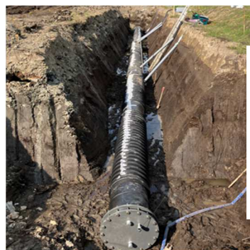
図 21. 試験施工状況
