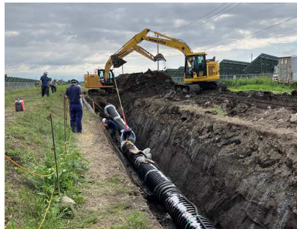
図 22. 供試管布設状況
