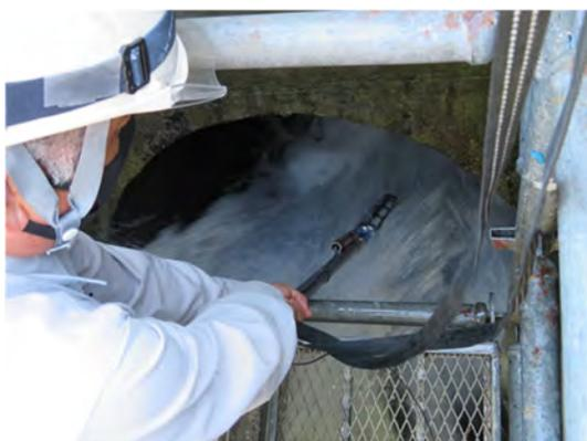
写真4 ロボット発射
