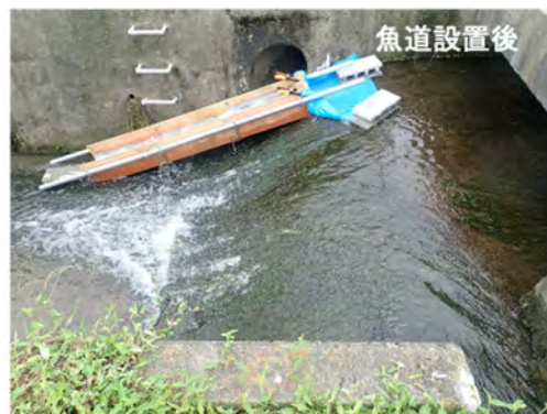
図 1.7-1 現場に設置した 2 号魚道
