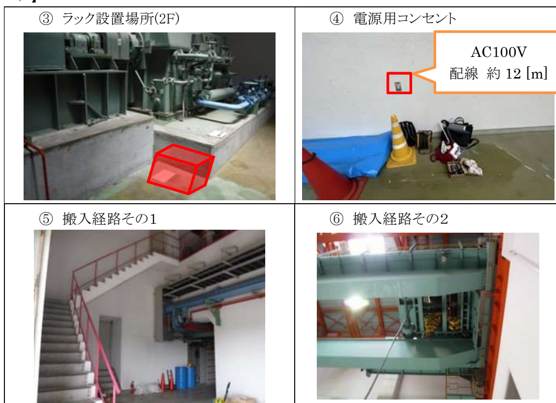
図 1-5 センサーの設置、搬入経路並びに電源位置の確認
