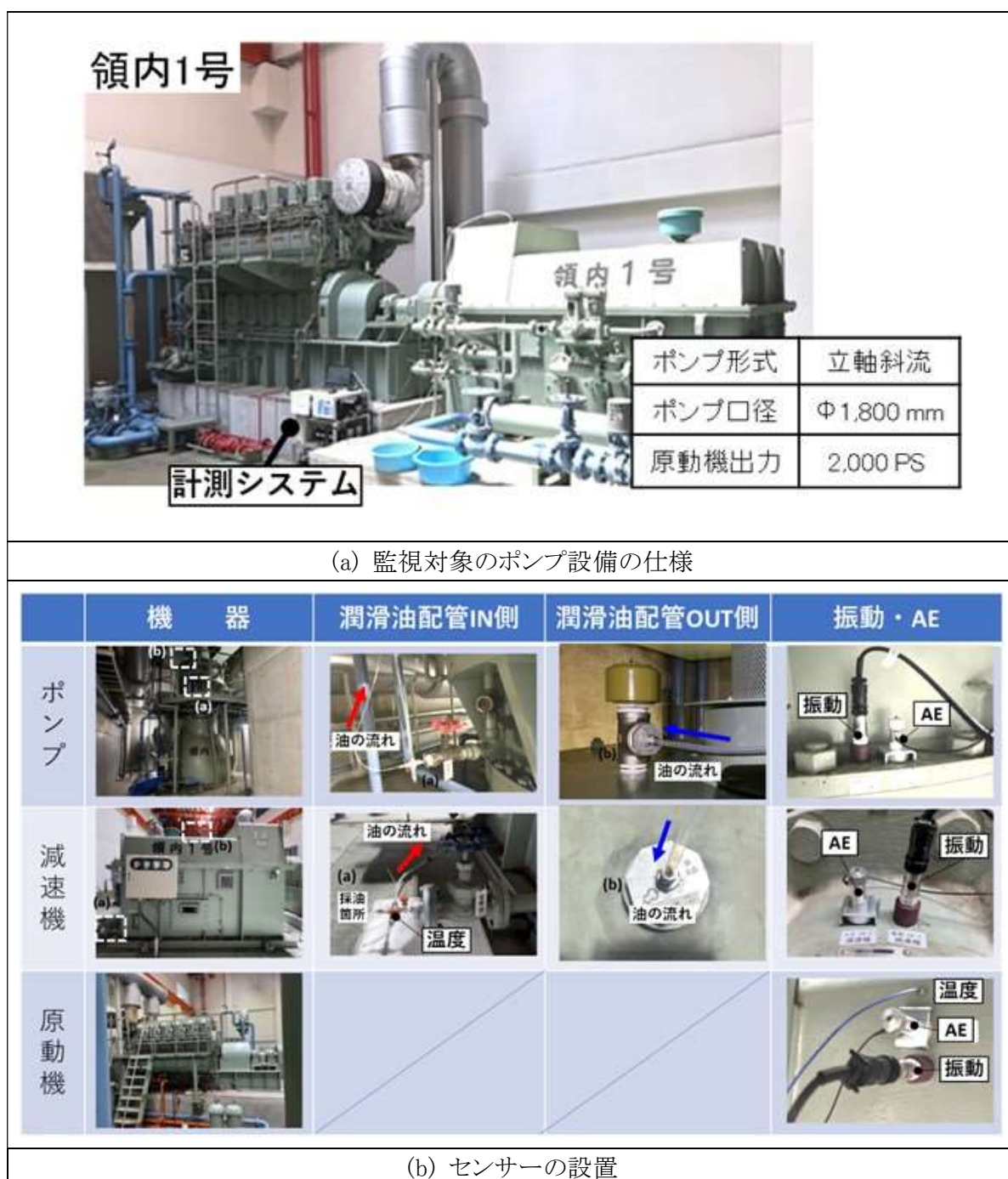
図 1-9 各監視対象に対するセンサーの設置
