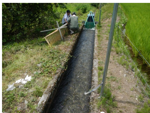
除塵機設置前
