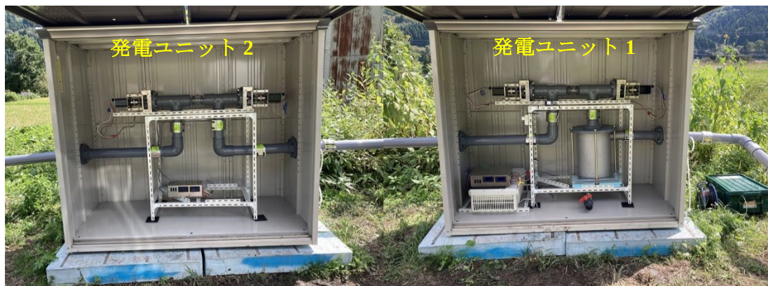
図 48 連結検証状況
