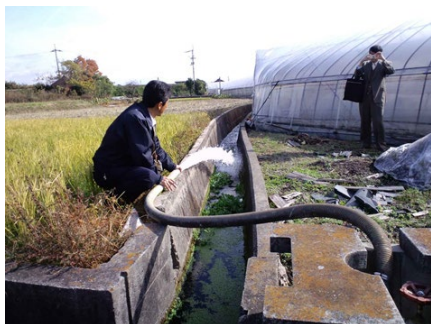
図 1 管路式農業用水給水栓
