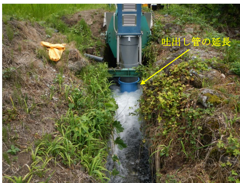
図 40 吐出し管の延長
