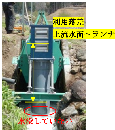
図 7 吐出し管の現況
