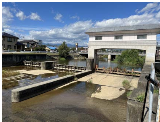
図 1.7.1-1 一の堰頭首工
