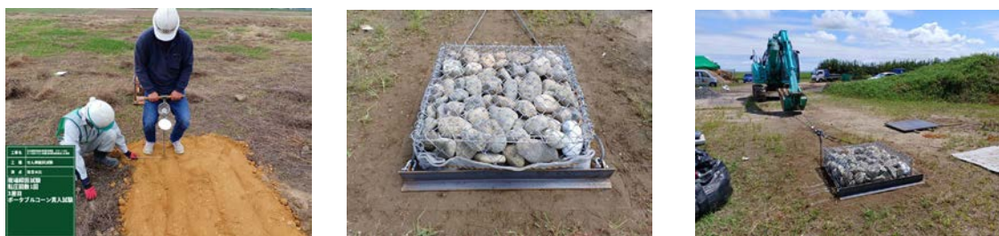
写真-4 試験状況写真
