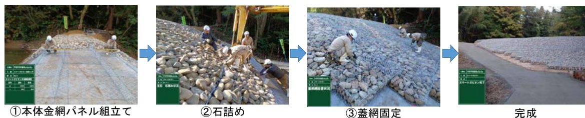
写真-2 スマートガビオン施工手順
