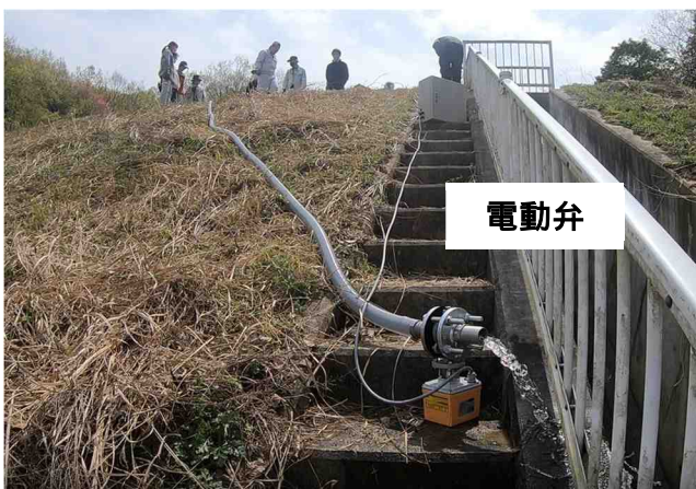
図 1 . 7 - 3 水位計と電動弁の制御
