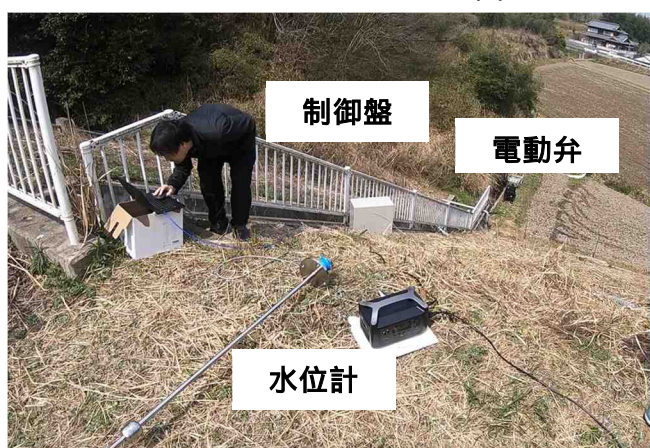
図 1 . 7 - 3 水位計と電動弁の制御
