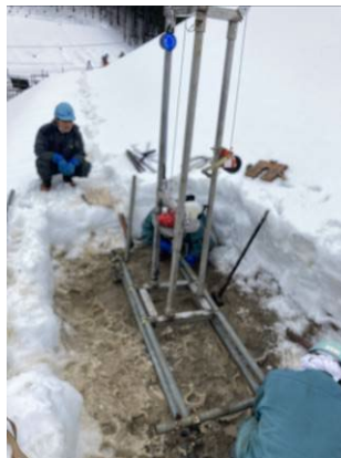
写真 1.6.5 削孔機の固定状況
