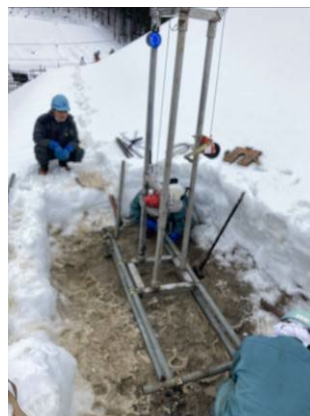
写真 1.6.5 削孔機の固定状況
