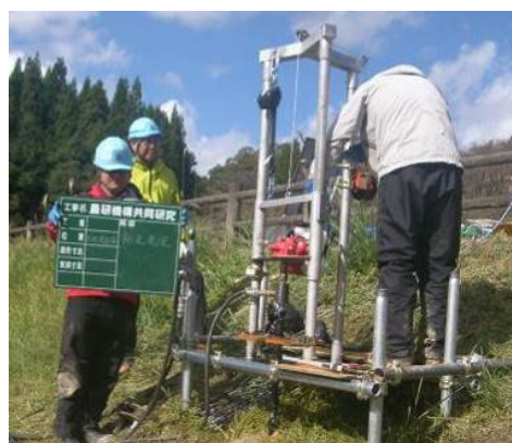
写真 1.6.3 縦型簡易削孔機掘削状況
