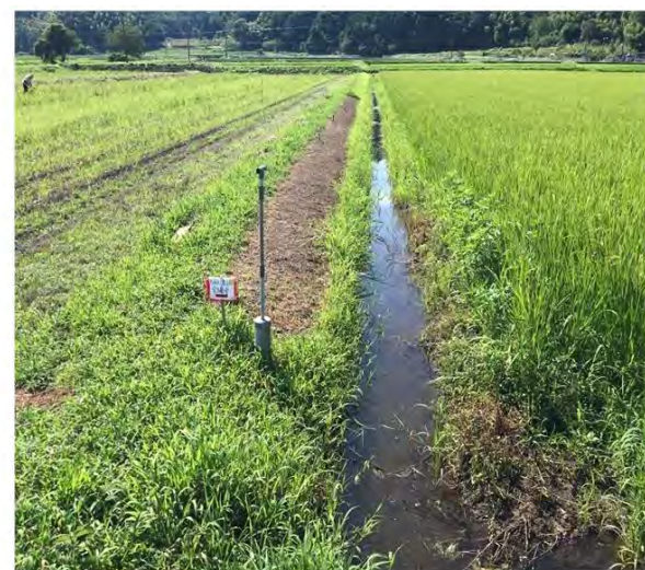
第1回目ムカデ芝張付作業完了(令和3年8月5日)
