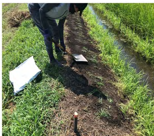
第1回目ムカデ芝転圧作業(令和3年8月5日)
