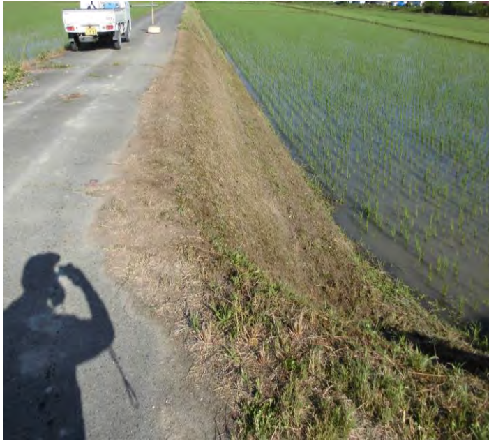
枯れ葉の地上部 刈取り
