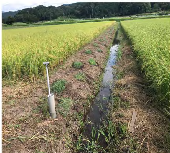
第2回目ムカデ芝張付作業完了(令和3年8月31日)
