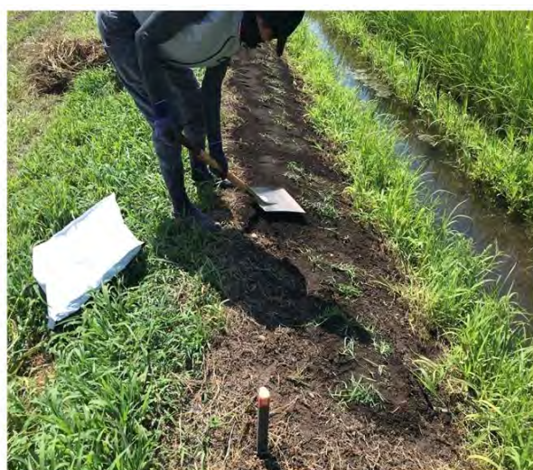
第1回目ムカデ芝転圧作業(令和3年8月5日)
