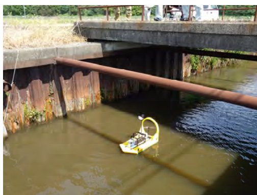
写真 1.6.3 機種 D 水上 UAV 航行状況
