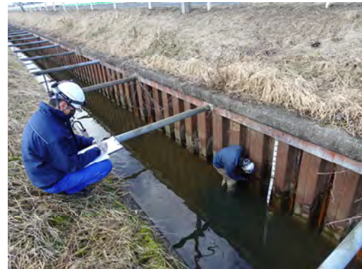
写真 1.6.5 亀田排水路上流部調査状況
