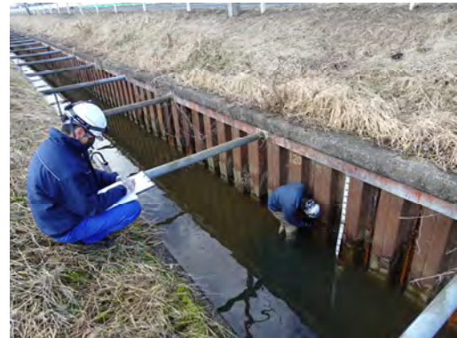
写真 1.6.5 亀田排水路上流部調査状況
