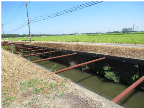
写真 1.6.1 山崎排水路 状況写真
