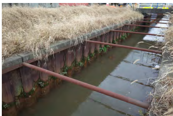
写真 1.6.6 大石排水路現場状況
