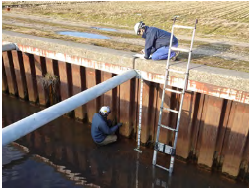
写真 1.6.4 袋津排水路調査状況
