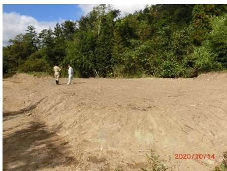
(1) 実証試験ヤード
