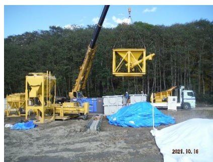
(50) プラント解体
