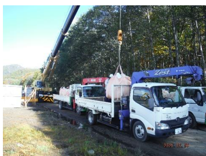
(53) 機能監視用改質土積込
