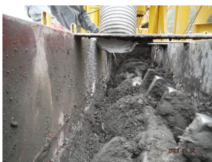
(43) 混練状況 (撮影のためカバー取外し・停止)
