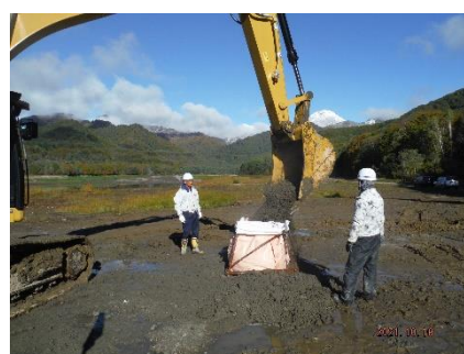
(52) 機能監視用改質土土嚢詰
