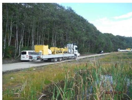
(51) プラント機材搬出
