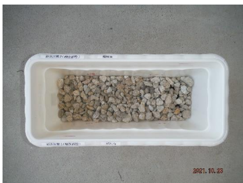
写真 1. 8-15 鉢底石敷均し
