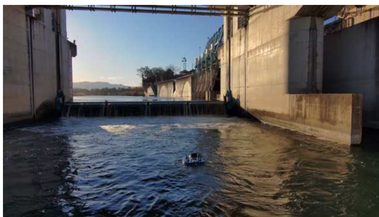
図-20 堰下流の流れのあるところでの試験航行状況
