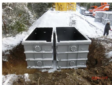
(12) 貯泥用水槽埋設
