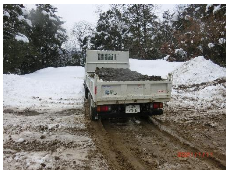
(19) ため池底泥土搬入
