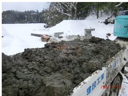
(21) ため池底泥土
