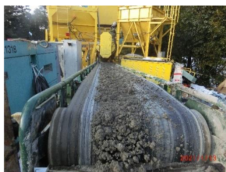
(28) 土壌用改質土排出
