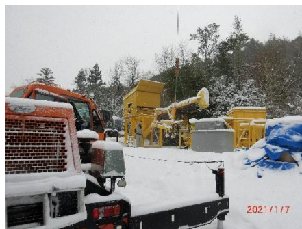
(14) 処理プラント組立
