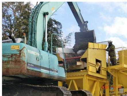
(22) ため池底泥土投入
