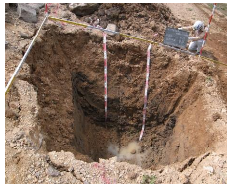
写真-4.4.2.2 TR-1 テストトレンチ
