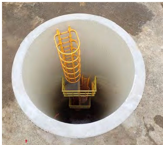
図 2-2-1-1 フローリング内巻補強工法
