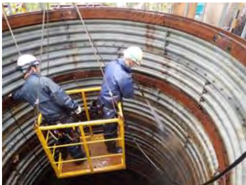
図 1-6-8-4 高圧洗浄状況
