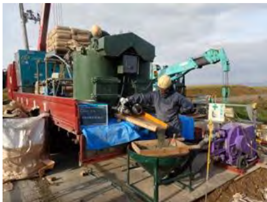
図 1-6-8-7 混練状況（地上プラント）
