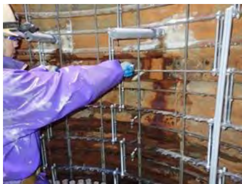
図 1-6-8-5 鋼製リング組み立て状況
