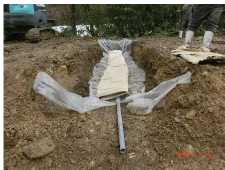
(g) 吸出防止材敷設
