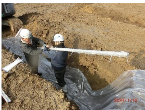
(e) フィルター材取付
