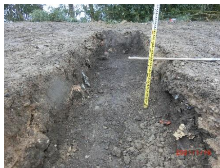
(b) 床掘完了
