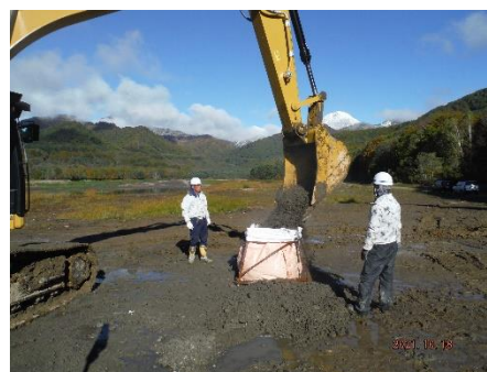
(d) 農業土木用改質土土嚢詰め（新潟）
