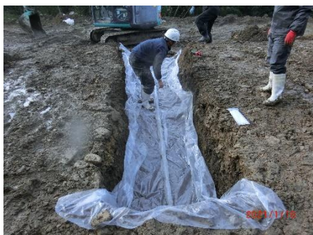
(e) 集水管 (VP40) 敷設
