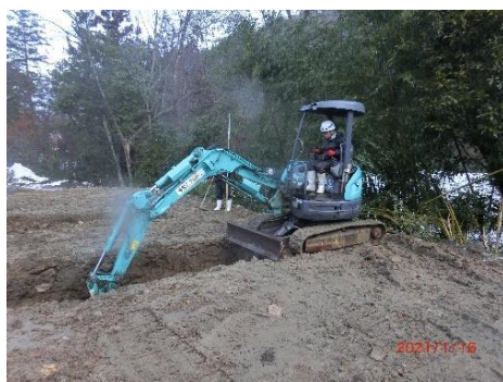
(a) 掘削・床掘
