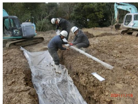
(d) 集水管フィルター材取付
