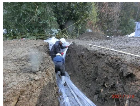
(f) 集水管敷設
