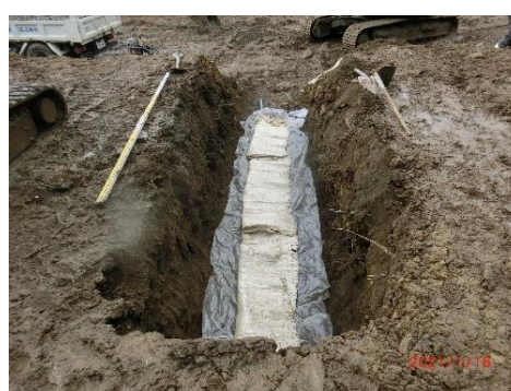
(h) 吸出防止材敷設
