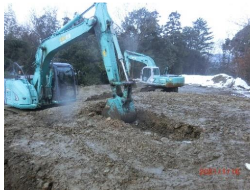
(b) 掘削・床掘
