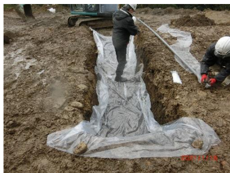
(c) 集水シート敷設
