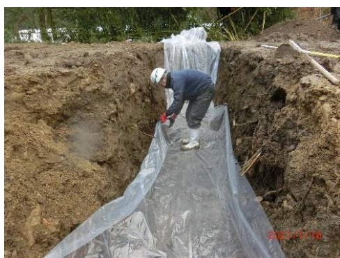
(c) 集水シート敷設
