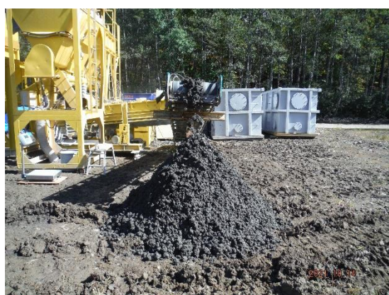
(3) 排出された改質土
