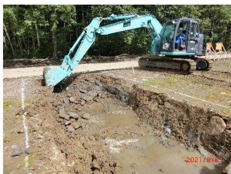
(3) 貯泥水槽床掘
