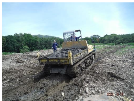
(11) 底泥土運搬状況
