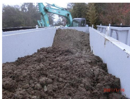
(36) 土木用改質土保管
