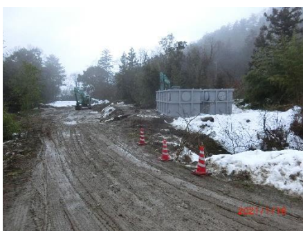
(39) 処理プラント搬出完了
