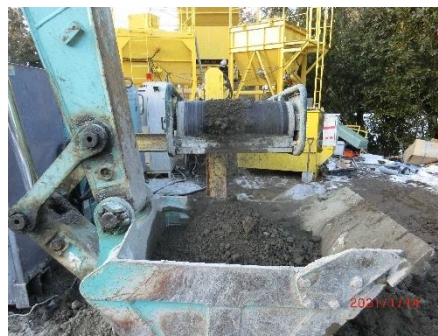
(34) 土木用改質土排出
