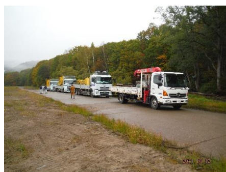
(20) プラント機材搬入
