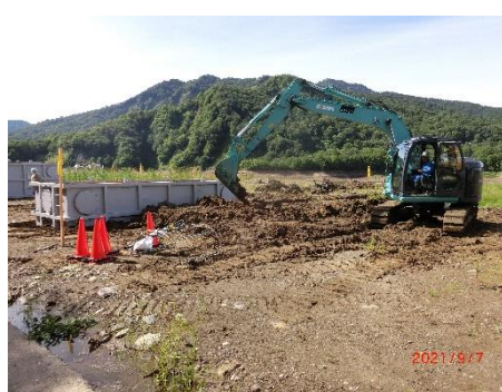
(6) 貯泥水槽埋戻し
