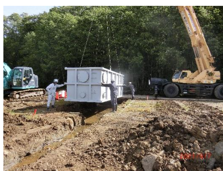
(5) 貯泥水槽埋設
