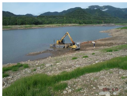
(10) 底泥土採取状況
