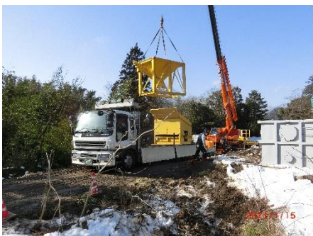
(37) 処理プラント解体
