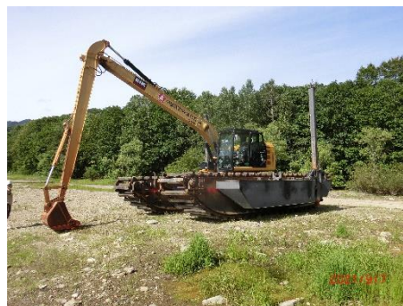
(8) 泥上掘削機組立完了
