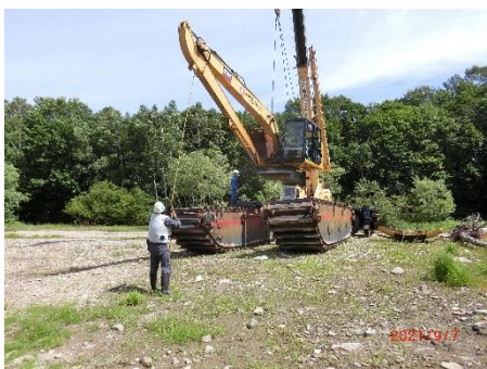
(7) 泥上掘削機組立
