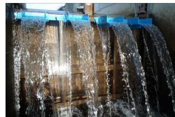
写真-6 樋型の流
