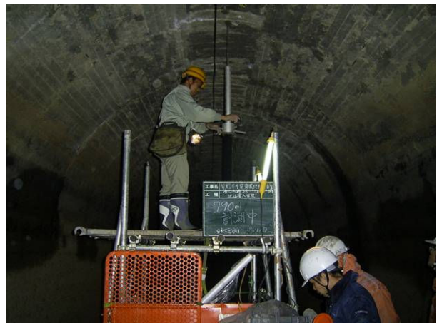
地山簡易貫入試験実施状況
