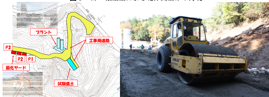
図7 大原ダムにおける実証試験
