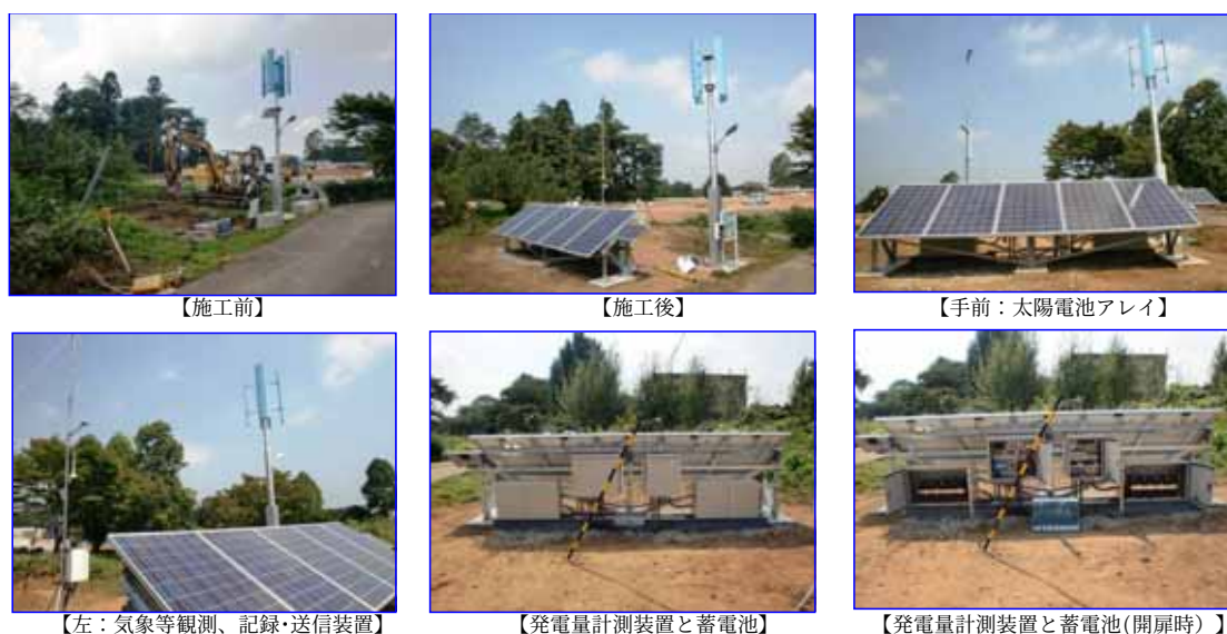
図 12 実証試験装置の設置
