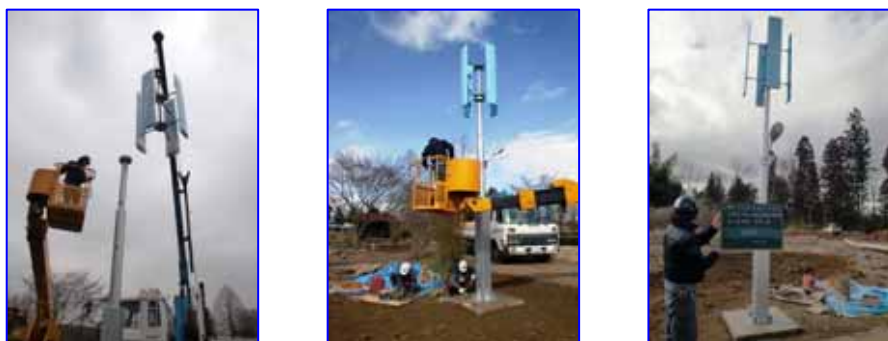
図 11 風力発電装置の設置
