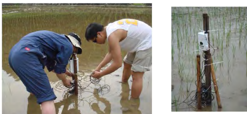
写真－2 土壌水分センサの設置作業風景と設置直後の WLA
