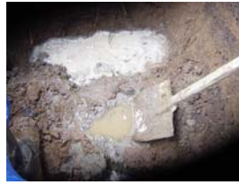
湿潤施工状態（法的対応）
