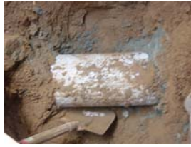
無処理施工状態
