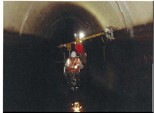
②レーダ計測状況
