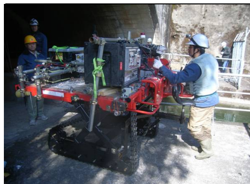
②自走台車の現場投入状況
