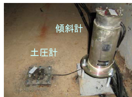
図-5 土圧計・傾斜計設置状況
