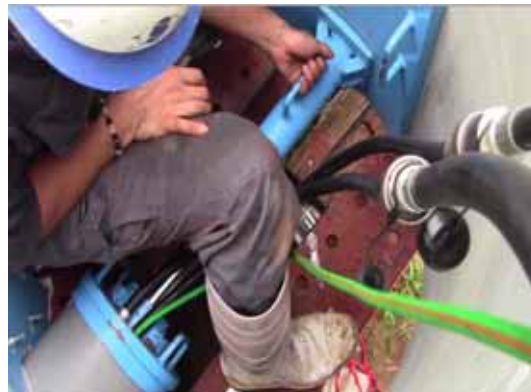
写真 6-18 ストラット設置
