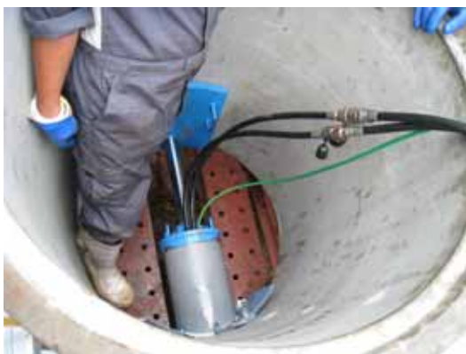
写真 6-17 ファイン管用推進機械にて推進
