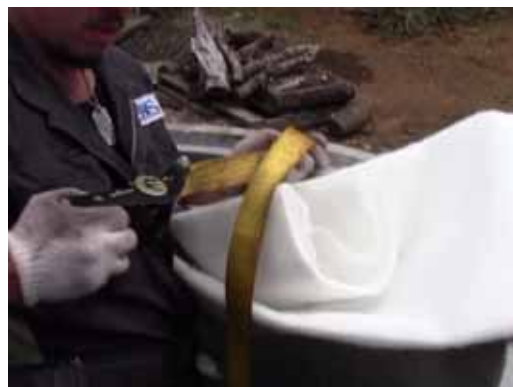
写真 6－10 FM材 引き込み段取り
