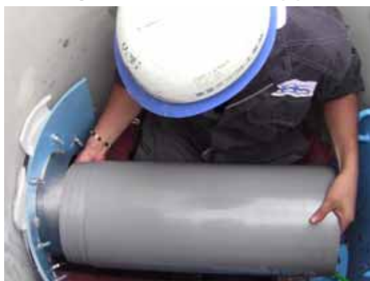
写真 6－13 先導管設置
