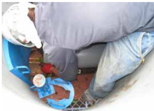
写真 6－15 ファイン管の接続
