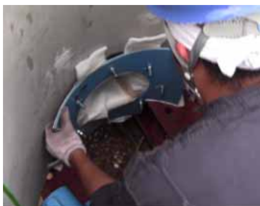
写真 6－11 FM材の固定
