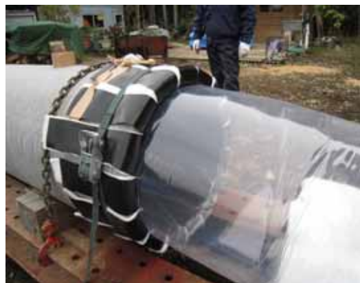
写真 6－12 拡径作業
