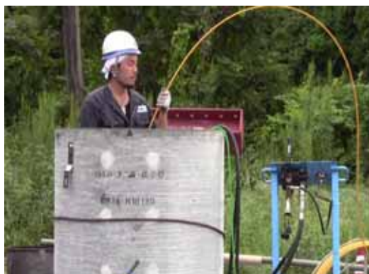
写真 6－9 FM材 引き込み段取り
