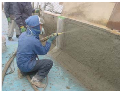
写真-10 吹付け施工状況
