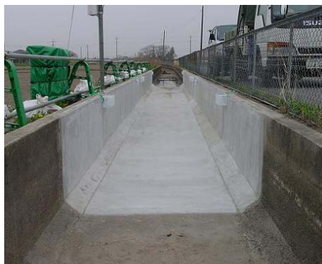
写真-9 実証試験箇所全景
