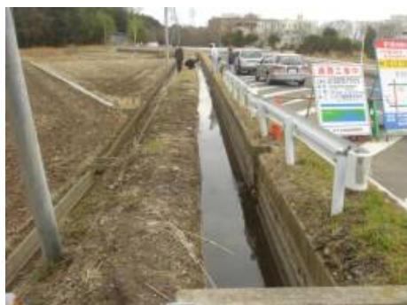
写真－8 試験施工箇所（茨城県）
