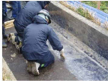
b) 貼付けプライマー塗布工
