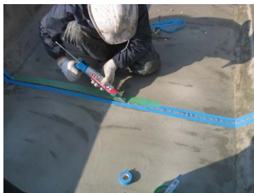
g) 目地部シーリング
