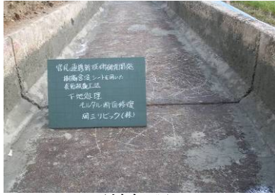
a) 目地部下地処理
