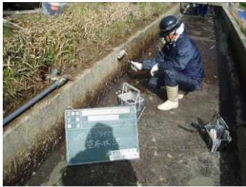
a) ベースプライマー塗布工
