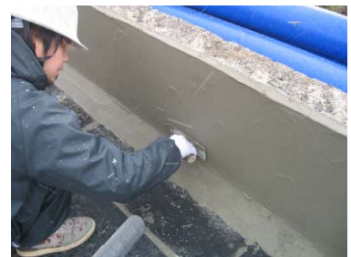
f) 上層モルタル塗布
