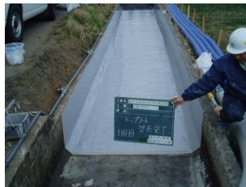
e) 施工完了 (ラインング部)
