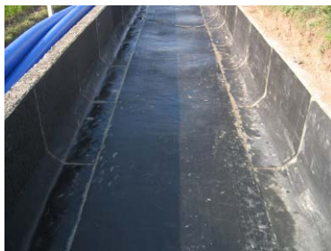
d) シート貼り付け完了
