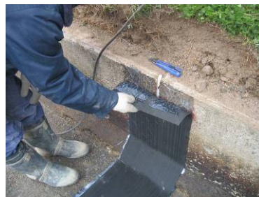
e) 目地部処理状況
