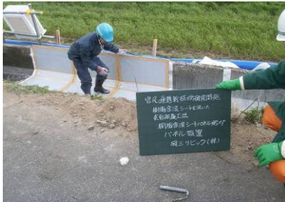
d) 被覆工設置
