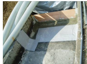
f) 施工完了 (目地部)
