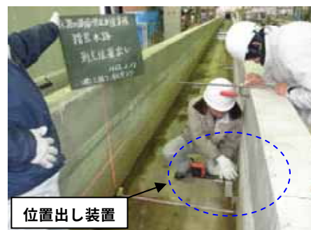
図-1.6.8 水路断面測定手法
