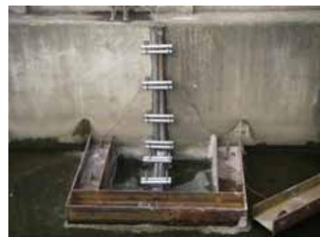
図-1.6.6 局所締切装置設置状況
