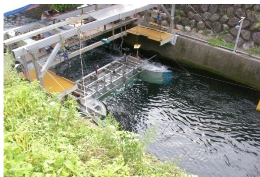
図 3 水車設置状況
