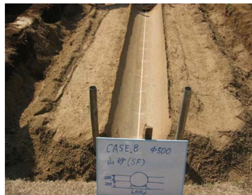
図10 図8の施工手順
